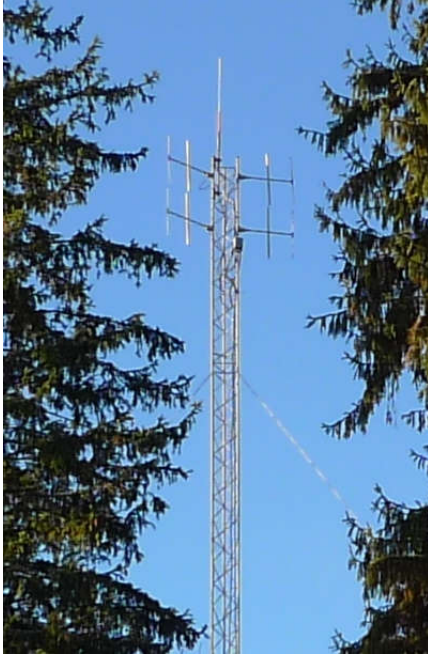
Vanhamäentien toistinasema (kuva OH4MM)
